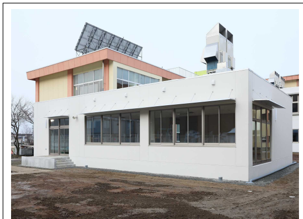
1 階教室棟外部
