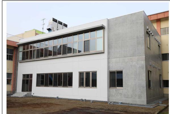
1 階教職員室・2 階ホール棟外部
