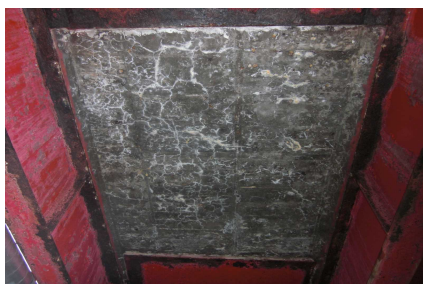
「橋面防水対策を施していない橋の床版(橋下面)状況」
