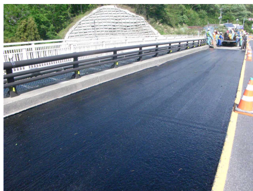
「橋面防水層散布状況」 【他自治体での事例】
