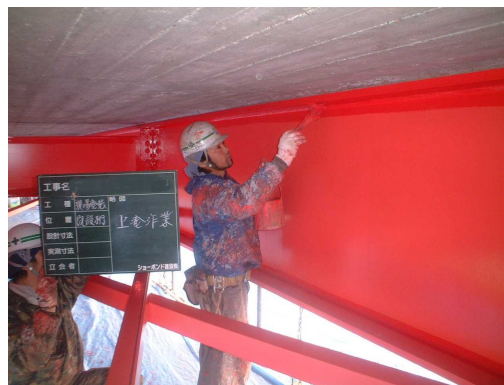
「塗り替え工上塗作業状況」 【他自治体での事例】
