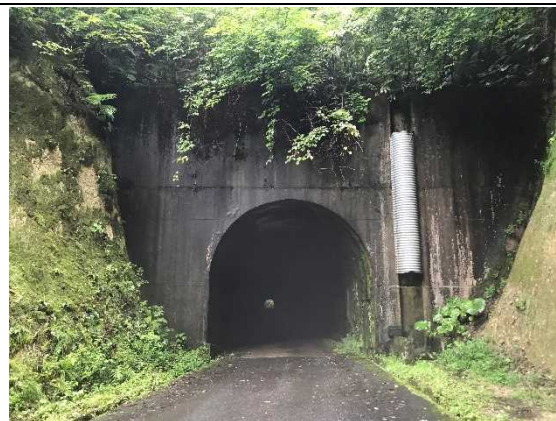
松倉トンネル
