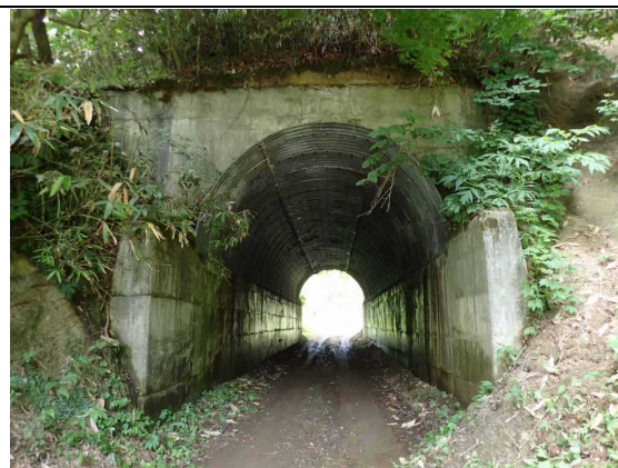
奥小比内トンネル
