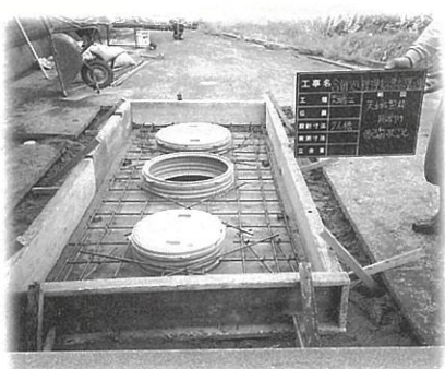
浄化槽設置作業
