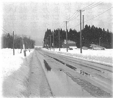
矢坂上野地区を通るバイパス（県道317号線）
