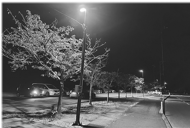
3基の外灯が新たに設置されました
