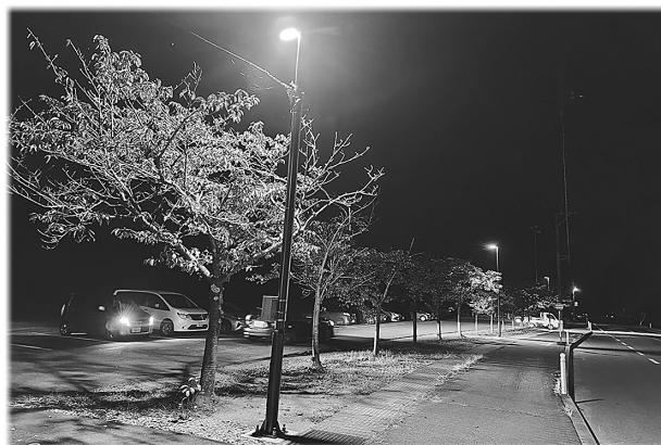
3基の外灯が新たに設置されました
