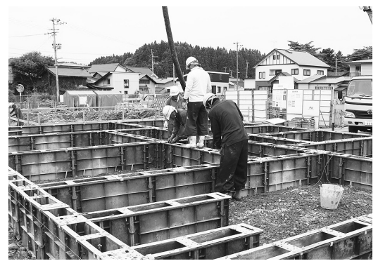
基礎工事に着手
